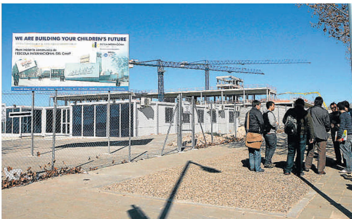
Estat actual de les obres de construcció de la nova escola
