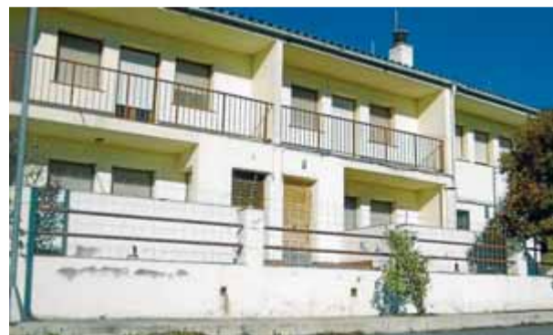
La caserna de la Guàrdia Civil d'Ulldecona està desocupada des de fa més d'un any ■ EL PUNT AVUI
